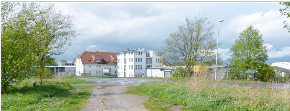
Blick vom Plangebiet zum Gewerbegebiet Am Hasensprung nördlich der L305 (April 2018)
