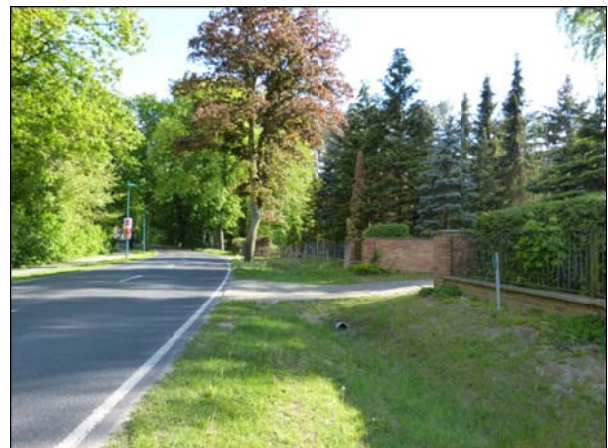
Blick von Nord entlang der westlichen Seite der Liebenwalder Straße (L21) im Bereich des Plan- gebietes
