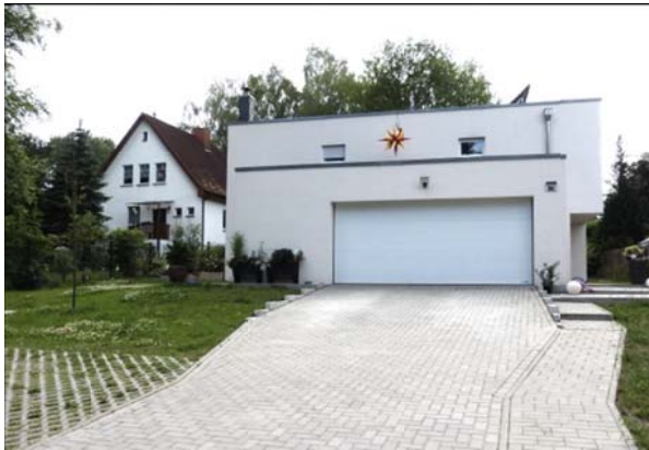
Wohnhäuser im Plangebiet
