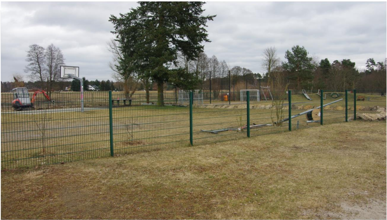
Die Arbeiten auf dem Bolzplatz wurden bei zunehmend kälterem Wetter realisiert.
