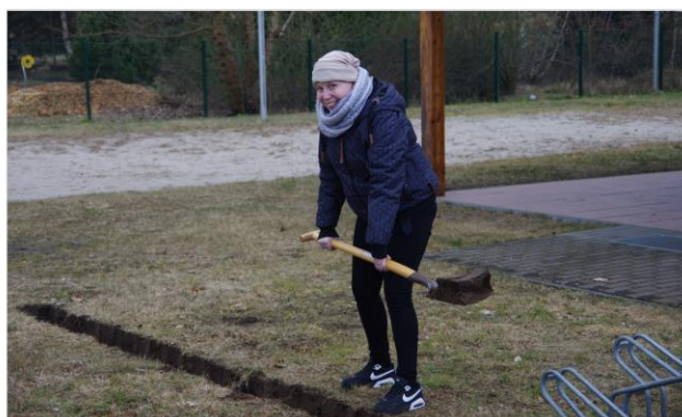
Ein Kabel wird durch unseren Garten verlegt. Wer kann hilft mit.
