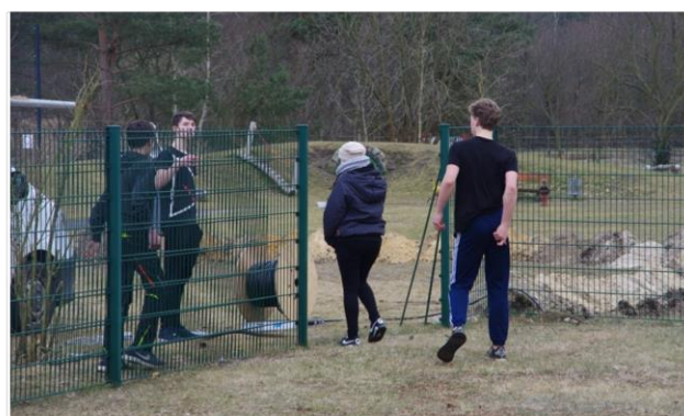
Fast 400 m Kabel wurde verlegt. Über 250m in der Erde.
