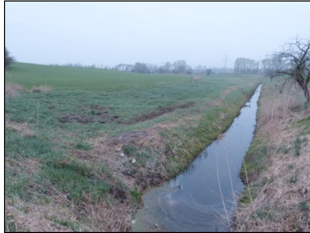
Der Schönwalder Südgraben, begrenzt das Plangebiet im Osten. Er ist ein technisch ausgebauter Entwässerungs-graben mit V-Profil, (Blick von Süd) April 2017
