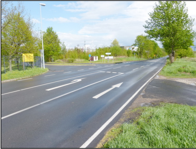
L 305 mit Einmündung der Straße Am Hasensprung und der Zufahrt auf der Seite des Plangebietes, Blick nach Ost (April 2018)
