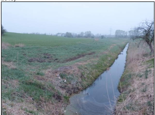
Der Schönwalder Südgraben, der östlich an das Plangebiet angrenzt, ist ein technisch ausgebauter Entwässerungsgraben mit V-Profil, hier Blick von Süd (April 2017)
