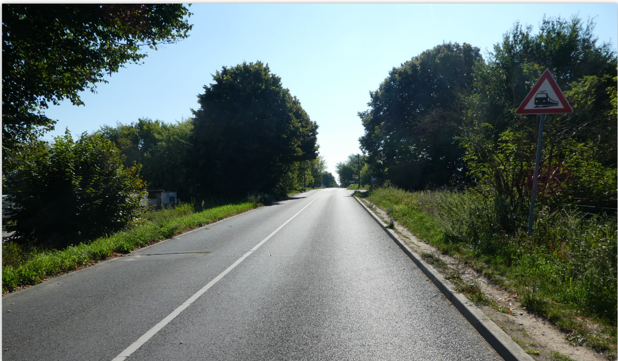
Abbildung 2-3 Pfad entlang der Bahnhofstraße (L305) | Blickrichtung Osten
