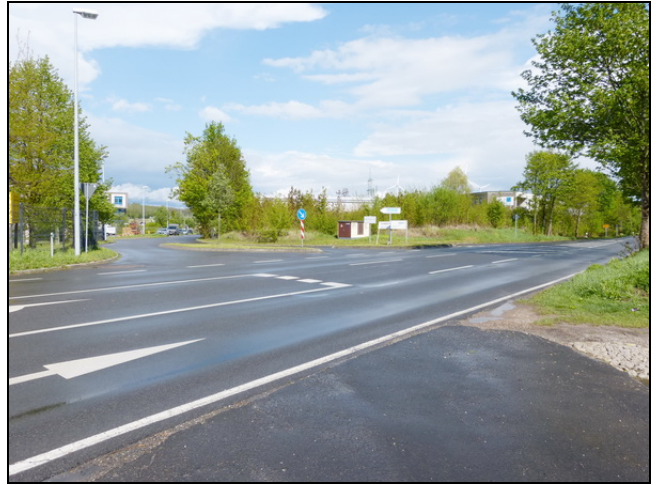
Blick vom Plangebiet in die Einmündung der Straße Am Hasensprung in die L 305 (April 2018)
