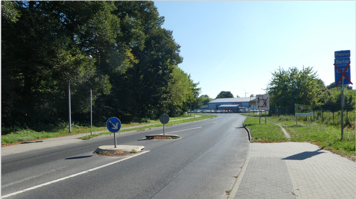
Abbildung 2-2 Querungshilfe am Ortsausgang Mühlenbeck an der Bahnhofstraße (L30) | Blickrichtung Osten
