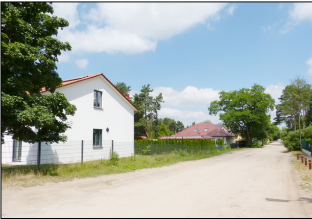
Wohnbebauung am Grünen Weg östlich des Plangebietes
