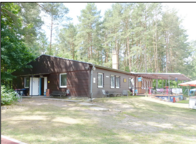
Funktionsgebäude, Blick von Nordost
