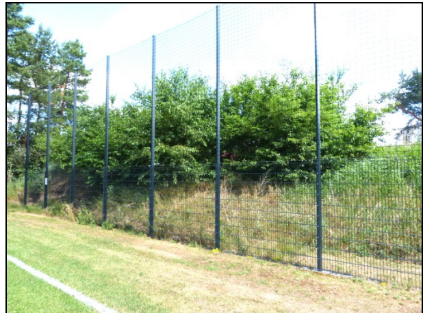
Erdwall nördlich des Fußballtrainingsplatzes
