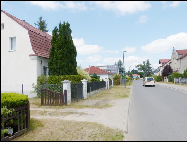
Wohnbebauung an der Basdorfer Straße nordöstlich des Plangebietes, im Vordergrund die Zuwegung zum Plangebiet
