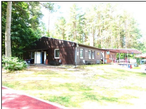
Klub- und Sanitärgebäude im Süden des Plangebietes
