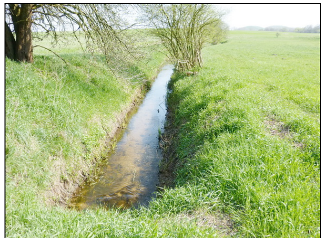
Schönwalder Südgraben, Blick von Nord (April 2018)
