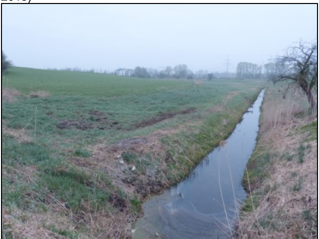
Der Schönwalder Südgraben, der östlich an das Plangebiet angrenzt, ist ein technisch ausgebauter Entwässerungsgraben mit V-Profil, hier Blick von Süd (April 2017)
