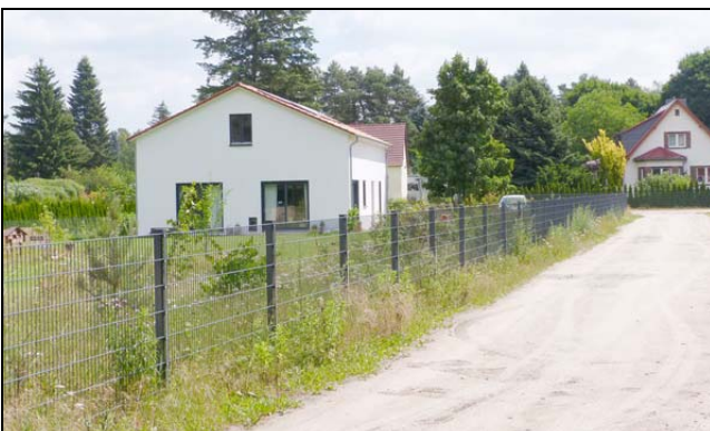
Wohnbebauung entlang der Zufahrt von den Stellplätzen des Sportplatzes zum Grünen Weg, Nordseite
