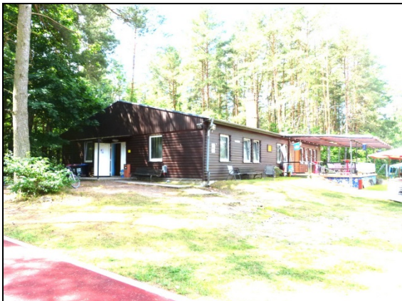
Klub- und Sanitärgebäude im Süden des Plangebietes
