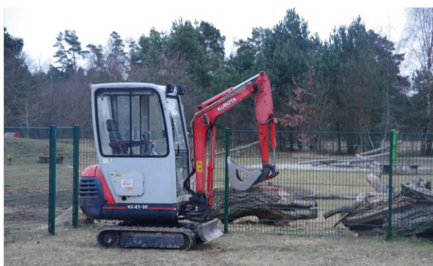
Für den Anschluss der 8 Laternen war schweres Gerät nötig.
